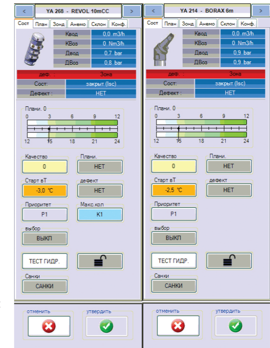
Система позволяет производить мониторинг любого снегогенератора на склоне в режиме online
